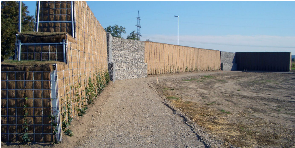
Abbildung 3 - Beispiel Erdwall - K-Nord - [k]nord - Lärmschutzwand begrünt 2022
