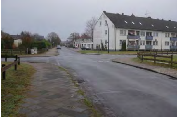
Abb. 100: Kreuzung Jägerhöhe/Auf dem Loh/Upaltenweg: hohe Bordsteine mit unregelmäßigen Absenkungen sowie sanierungsbedürftiger Straßenbelag
