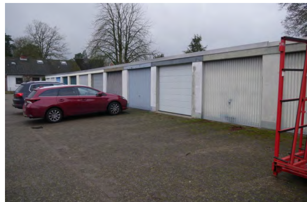
Abb. 85: Garagenzeile entlang der Benkheimer Straße
