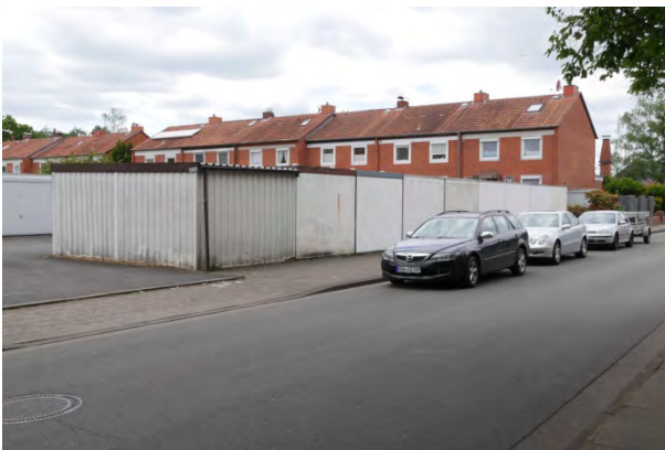
Abb. 31: Potsdamer Straße – keine Beziehung zwischen öffentlichen Straßenraum und Wohnbebauung
