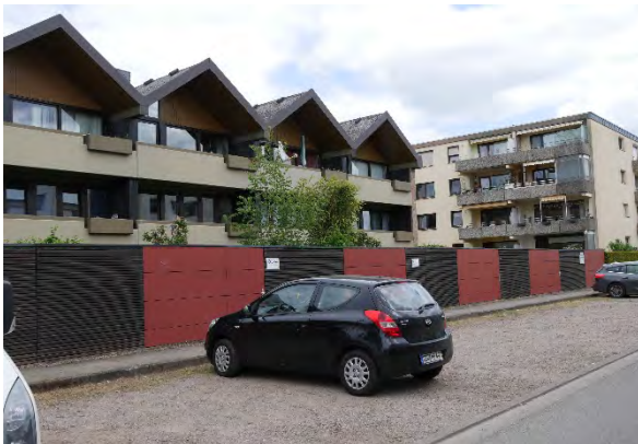
Abb. 42: Abgrenzung zum öffentlichen Straßenraum Wismarer Straße
