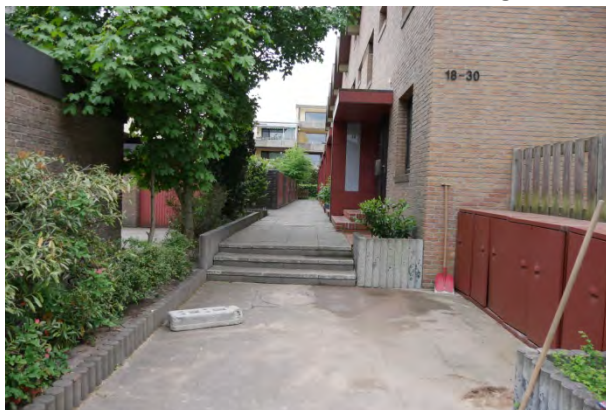
Abb. 12: Barriere Zugang Wohngebäude Wismarer Straße
