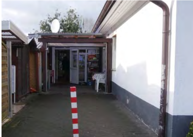
Abb. 24: Kiosk an der Fuhrenstraße
