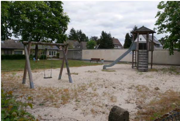
Abb. 60: Spielplatz Benkheimer Straße mit Garagenrückwand
