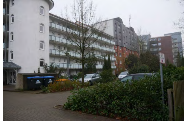
Abb. 7: Mehrfamilienhäuser Berliner Ring
