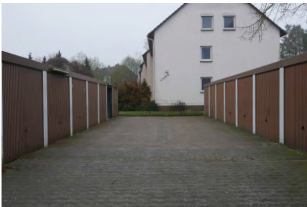
Abb. 84: Garagenhof an der Potsdamer Straße
