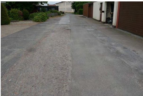
Abb. 80: Holzweg ohne Bordsteine
