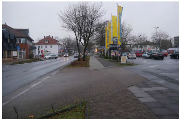
Abb. 91: Gefährliche Grundstückszufahrt Harburger Straße
