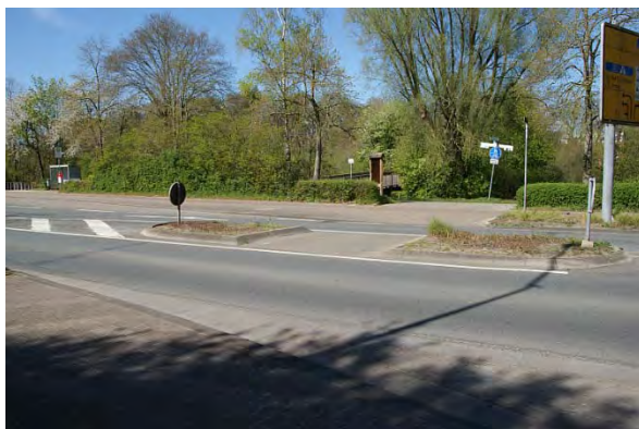
Abb. 77: Ungesicherter Übergang an der Aalter Allee
